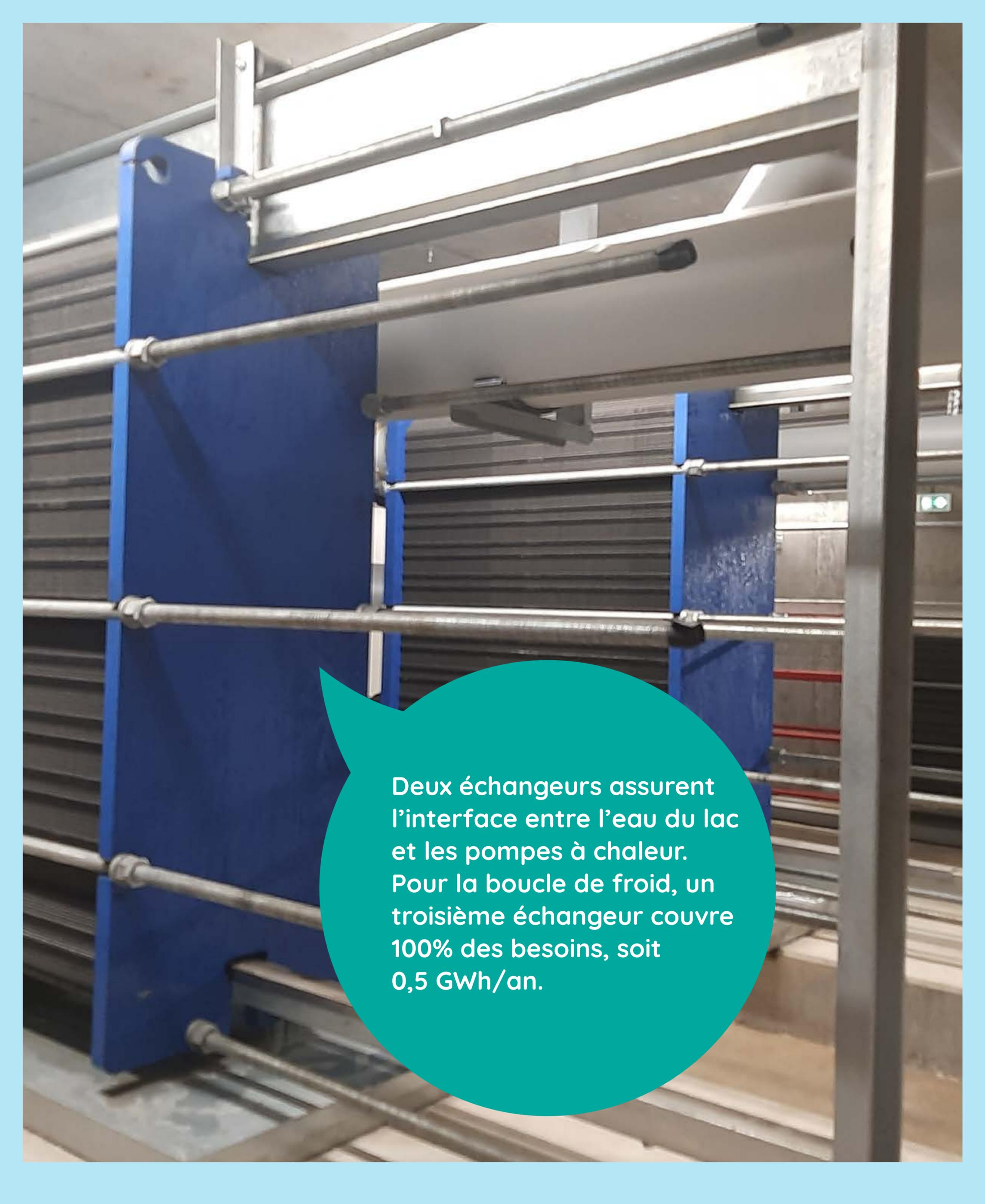
Deux échangeurs assurent l'interface entre l'eau du lac et les pompes à chaleur. Pour la boucle de froid, un troisième échangeur couvre 100% des besoins, soit 0,5 GWh/an.
