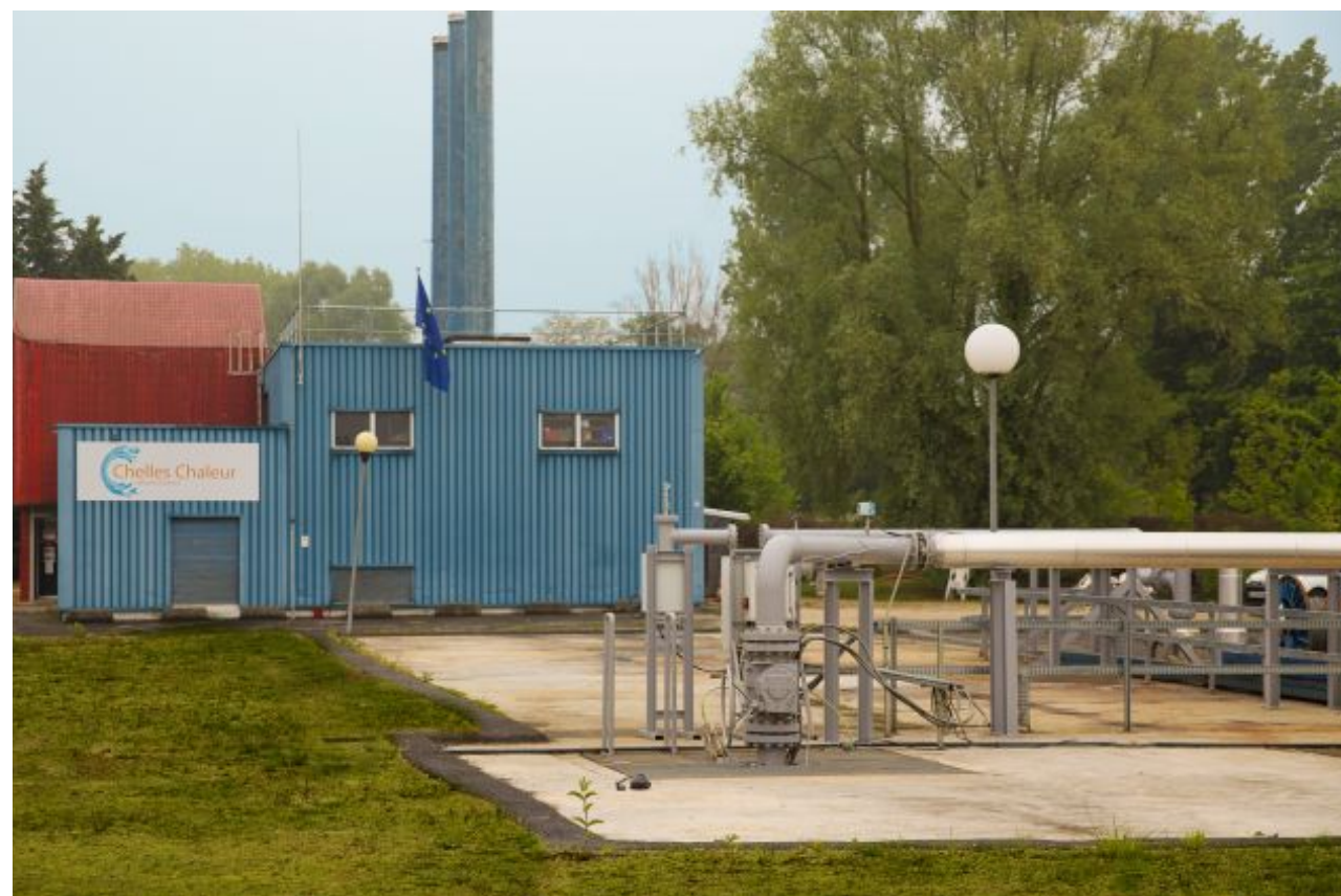
Forage de Géothermie profonde (Chelles)
